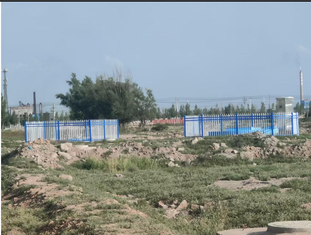
图 3-3 项目废水总排放口
