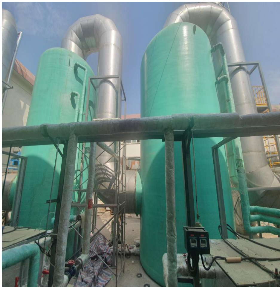
图3-4 喷淋洗涤塔2座
