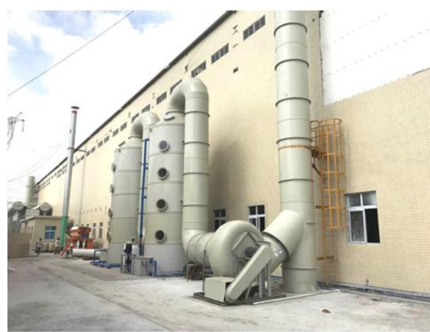
图 5.2-5 酸雾处理措施相同的现场照片
