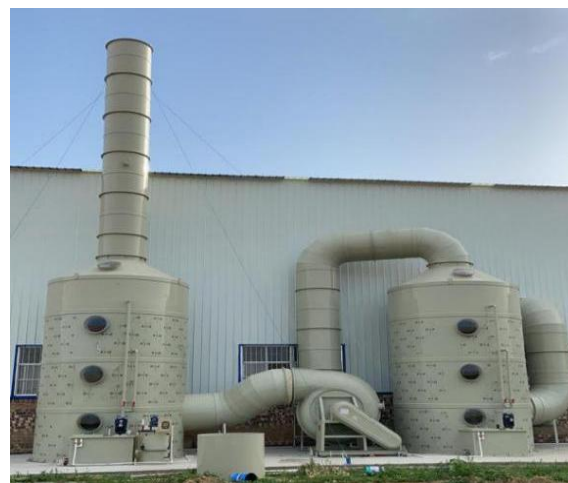
图 5.2-6 酸雾处理措施相同的现场照片
