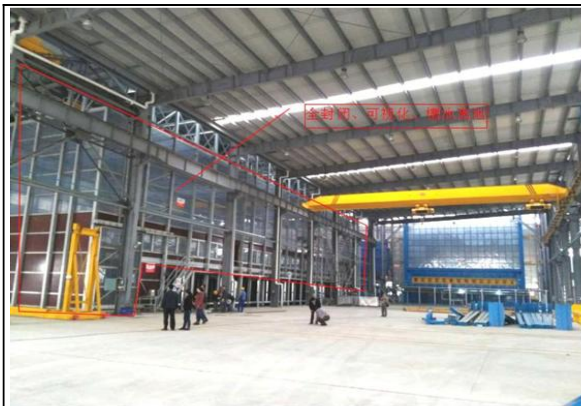
图 5.2-4 国内某建成的热镀锌企业酸洗、助镀区封闭房外景
