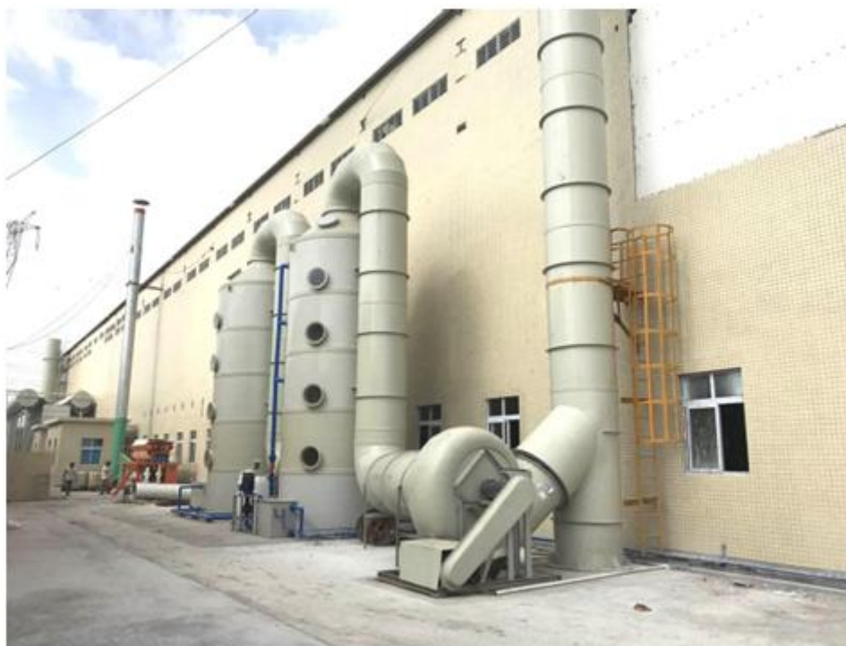
图5.2-5 与项目酸雾处理措施相同的现场照片
