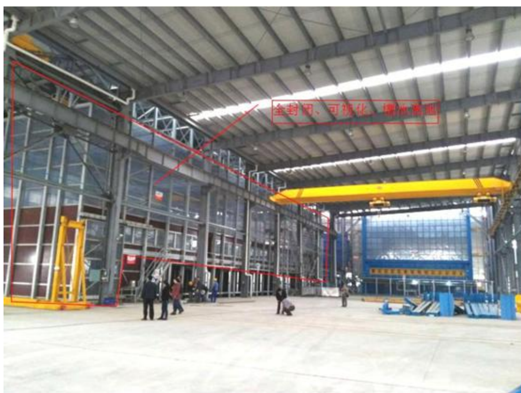
图5.2-4 国内某建成的热镀锌企业酸洗、助镀区封闭房外景
