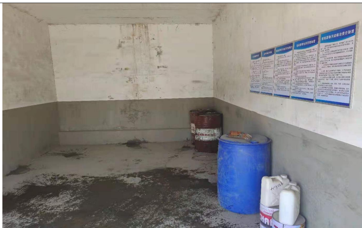
图 3-7 危险废物储存间
