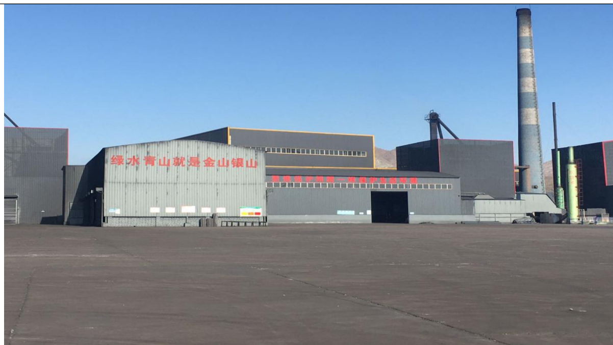
图 3-1 全封闭式普煅车间及破碎、筛分车间
