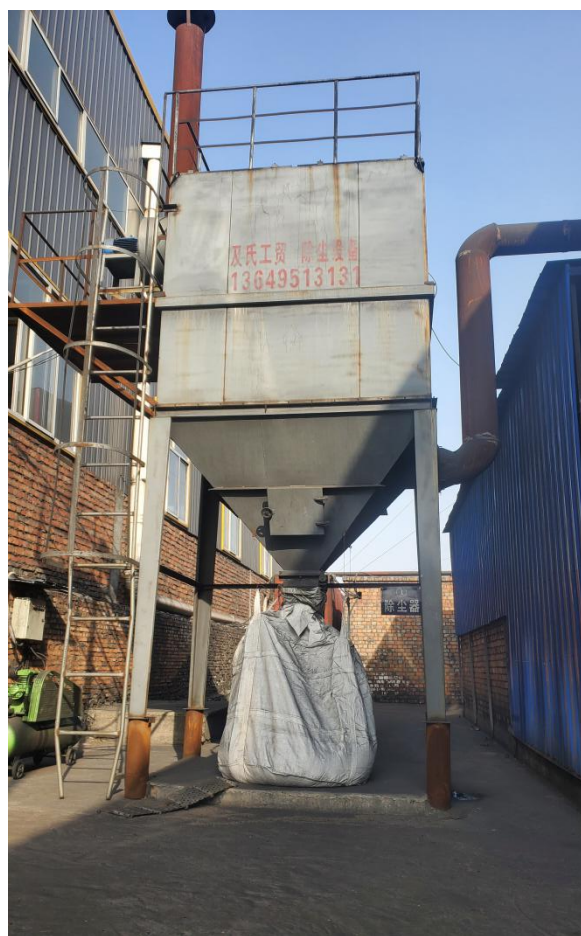
图 3-2 1#2#普煅炉袋式除尘器
