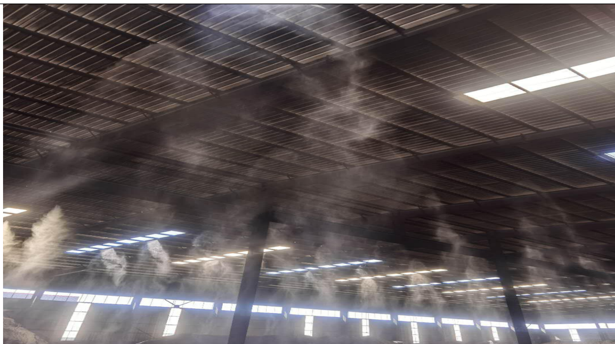
图 3-7 高压喷雾除尘装置
