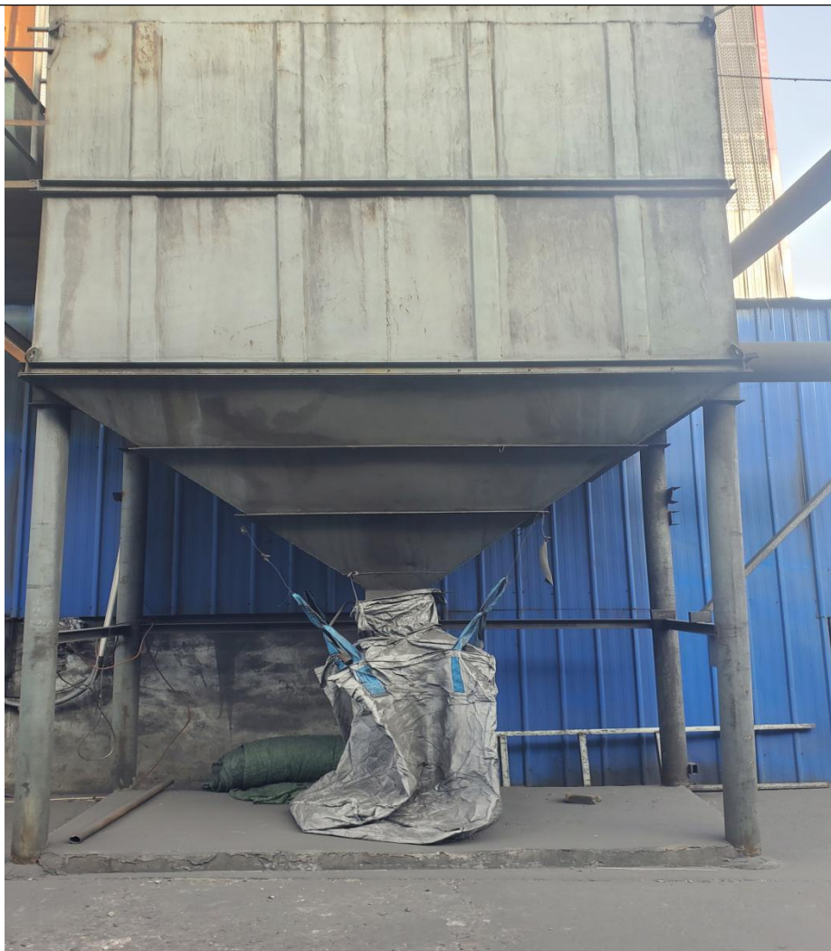
图 3-6 破碎、筛分工序袋式除尘器
