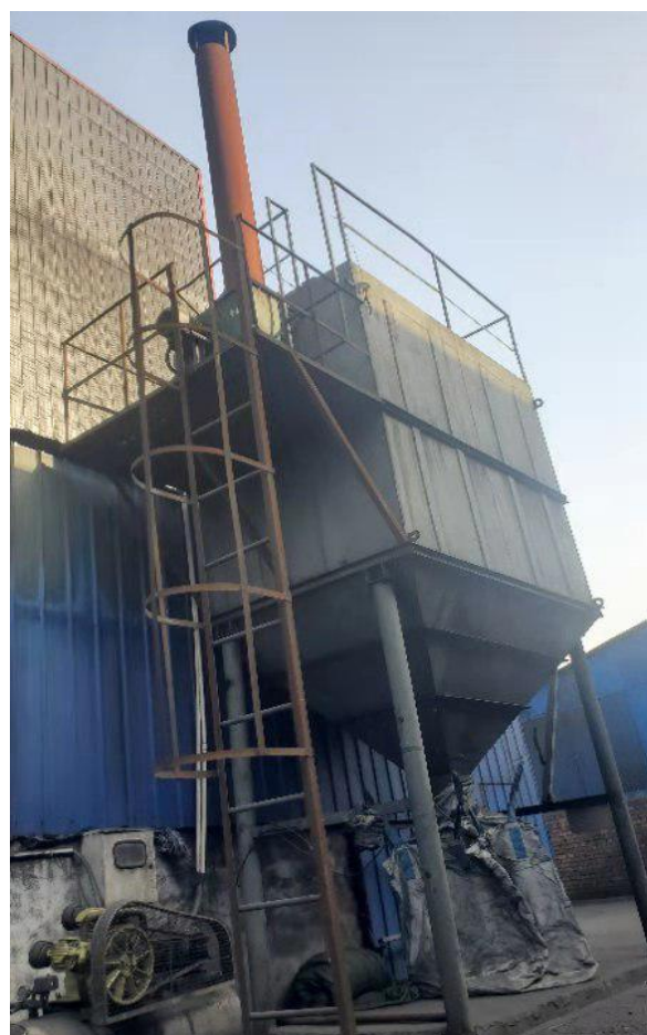
图 3-3 3#4#普煅炉袋式除尘器
