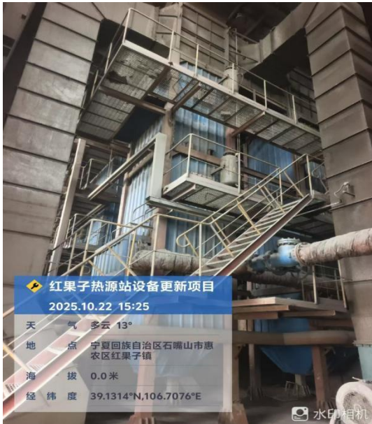
3#、4#链条锅炉（装于 2018 年，主用锅炉）
