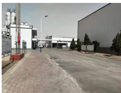
图3-12 厂区地面硬化
