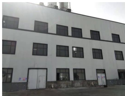
图 3-2 全封闭混捏车间
