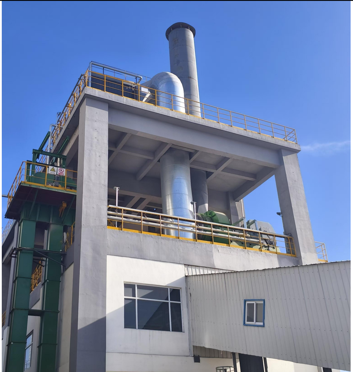
图 3-1 袋式除尘器+1 根 32m 排气筒（DA001）
