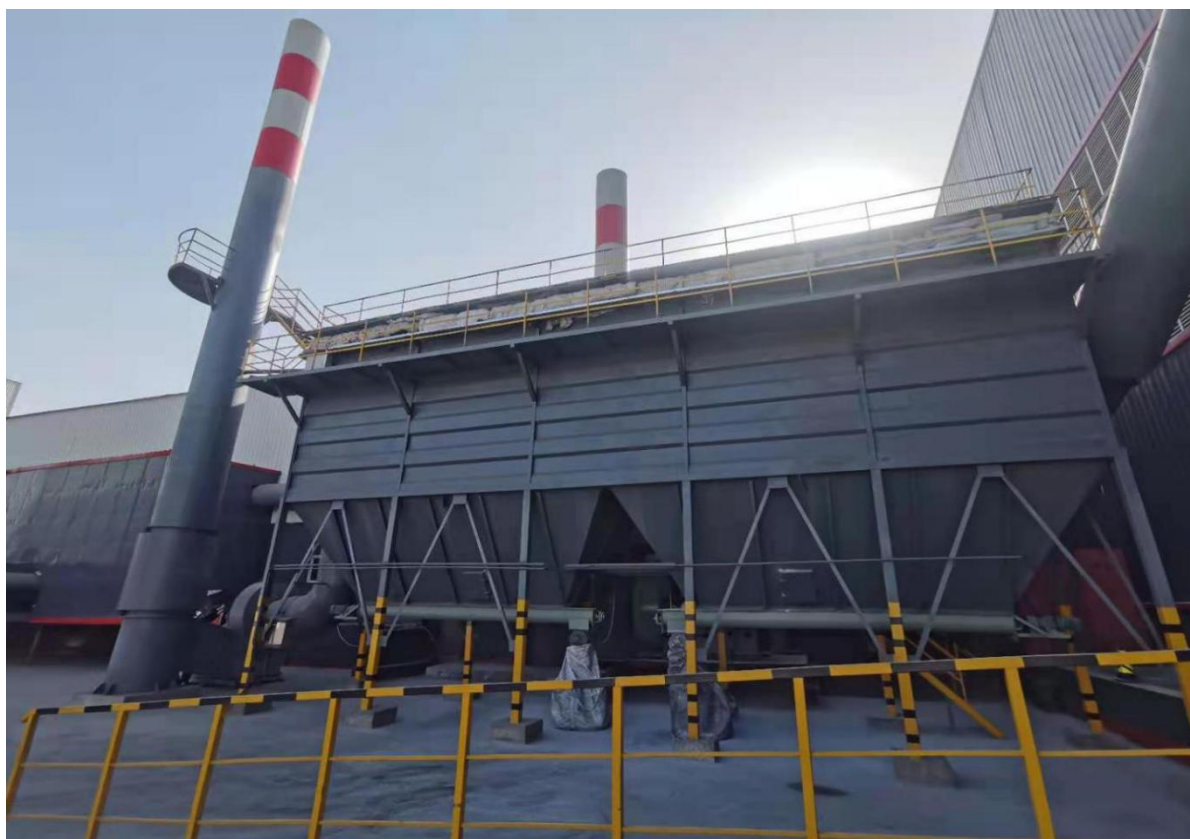
图4-2 中频电炉熔化及浇注工序带式除尘器
