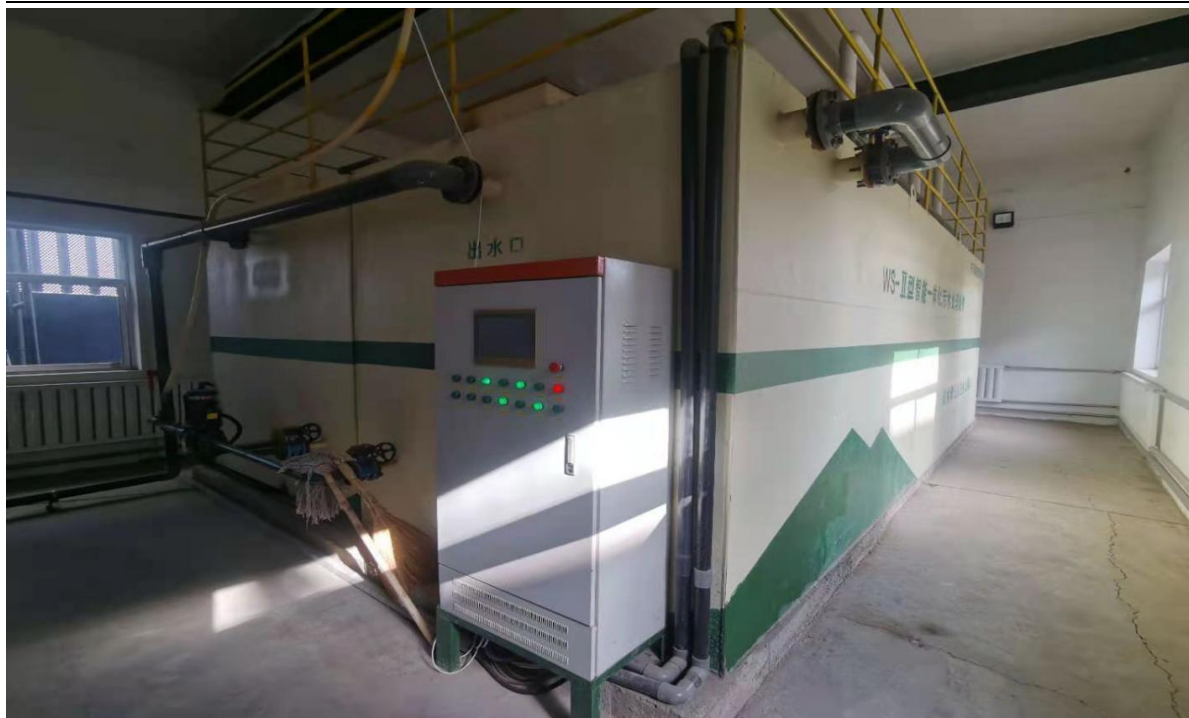
图4-5 MBR膜一体化污水处理设备
