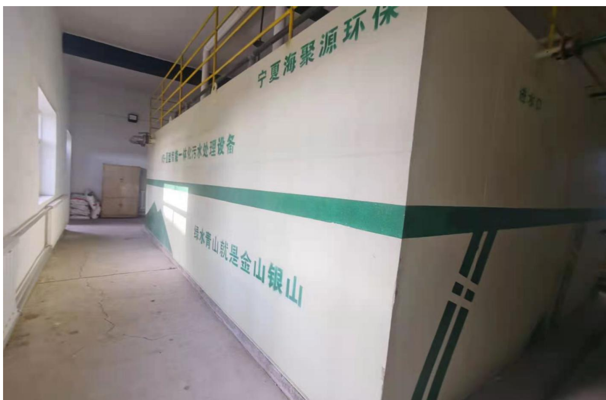
图4-6 MBR膜一体化污水处理设备
