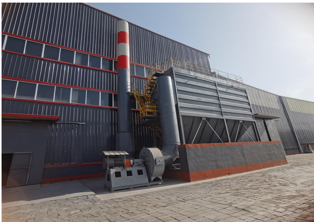
图4-4 破碎、筛分工序袋式除尘器
