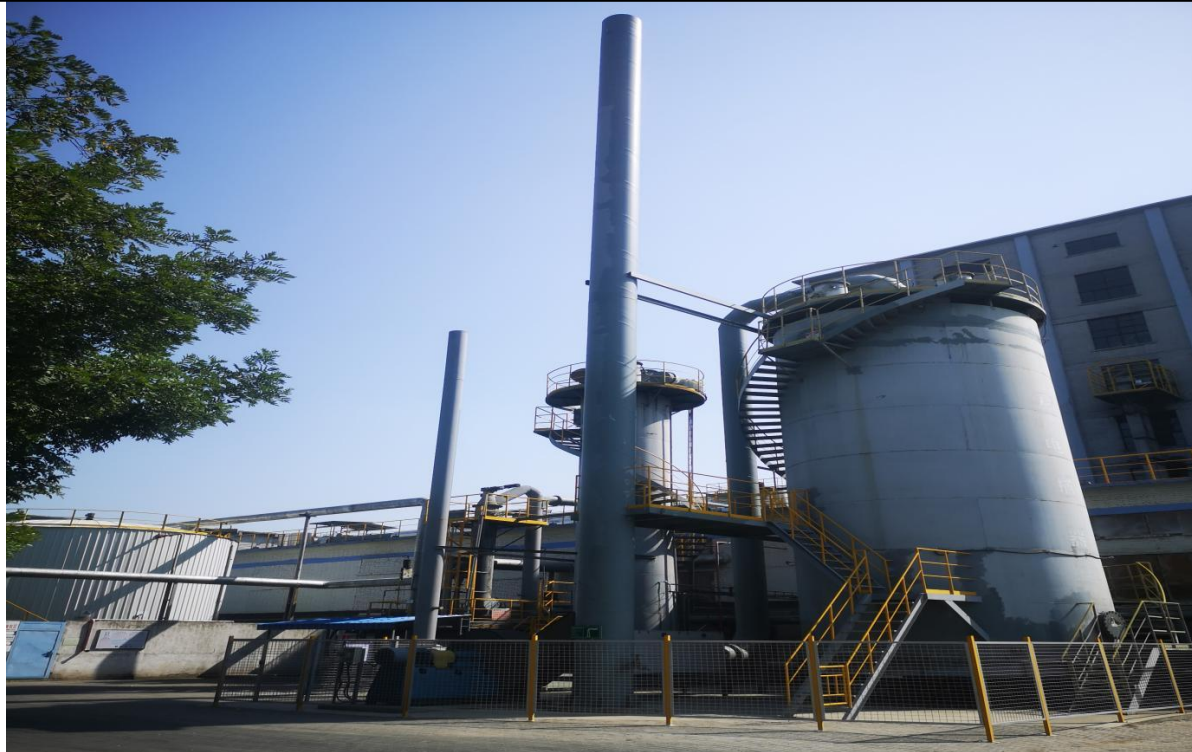
图 3-4 混捏、成型工序 2#电捕焦油器+活性炭一体机+25m 排气筒
