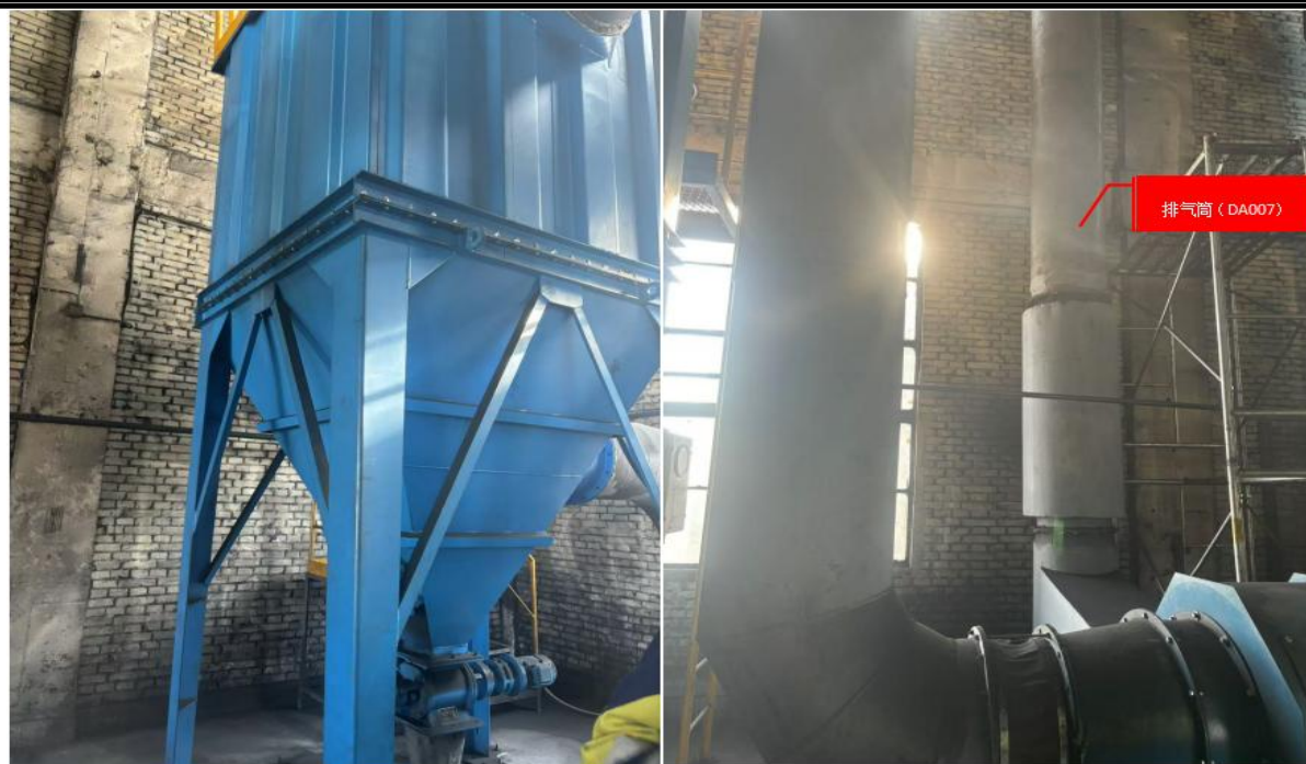
图 3-2 预热筛分工序布袋除尘器+滤筒除尘器+40m 排气筒
