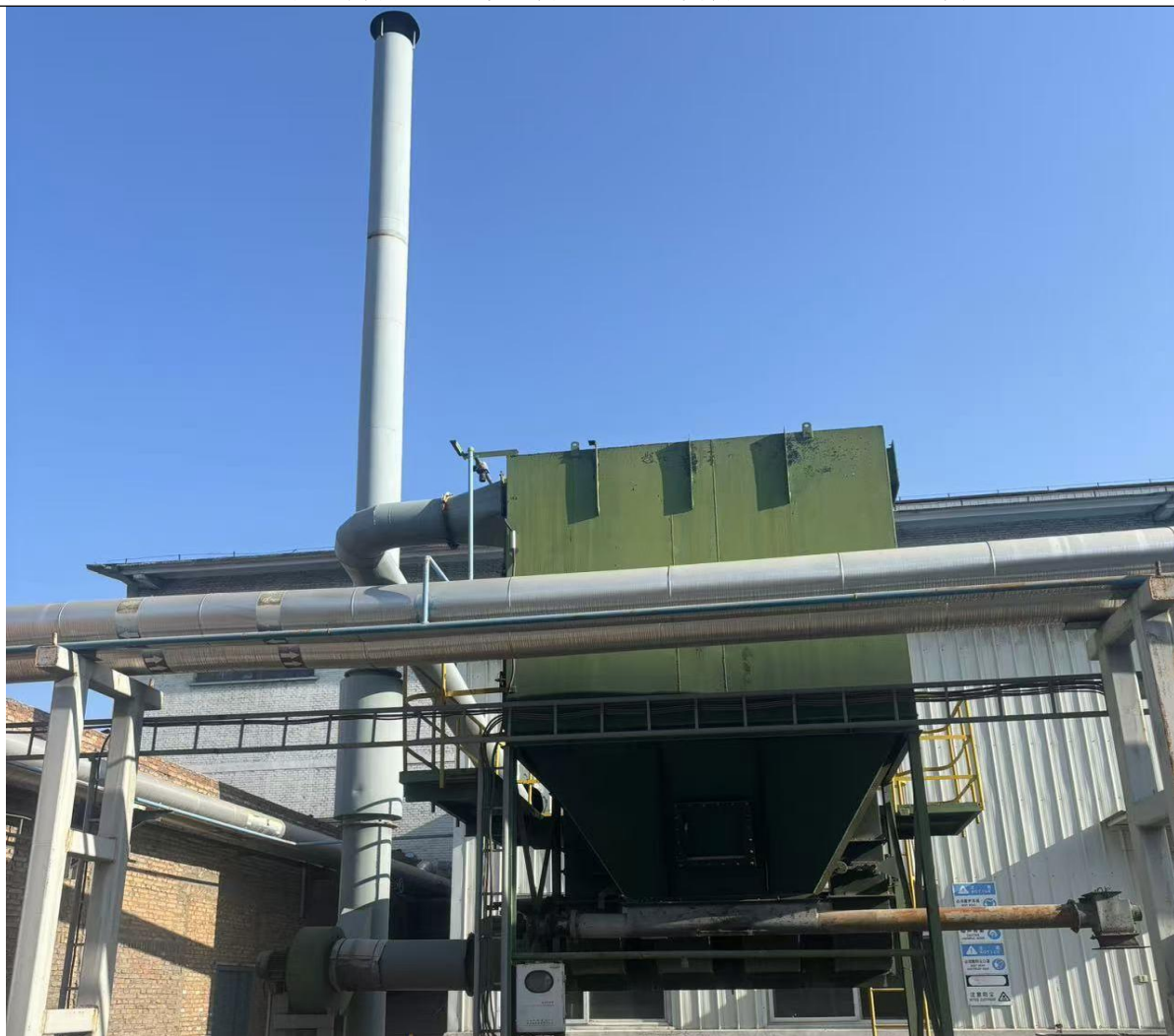
图 3-3 生料破碎工序布袋除尘器+15m 排气筒
