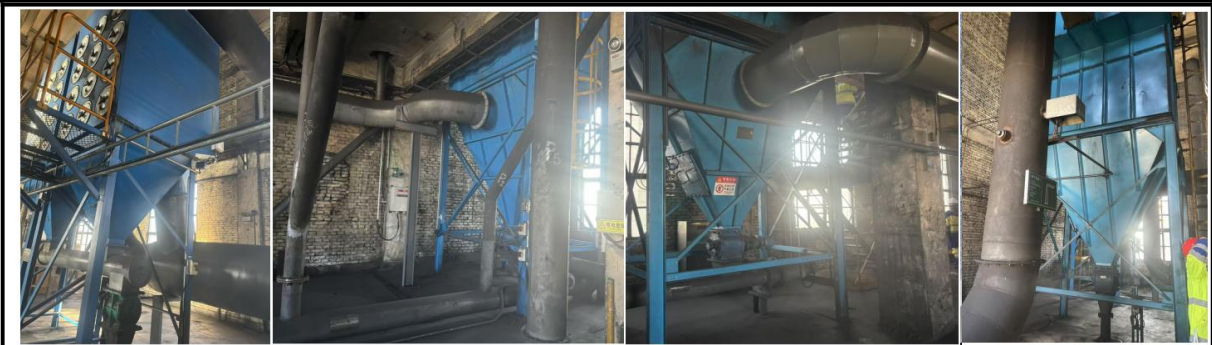
图 3-1 中碎工序布袋除尘器（3套）+滤筒除尘器（3套）+40m 排气筒
